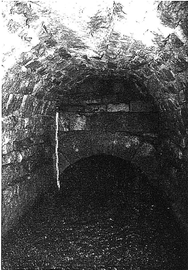
PHOTO 4. — Abbaye de Fontenay, passage du collecteur axial sous la clôture occidentale du monastère, le passage est protégé par un abaissement de la voûte.
