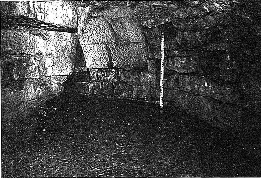
PHOTO 3. — Abbaye de Fontenay, virage du collecteur axial avant d'arriver à la clôture occidentale.
