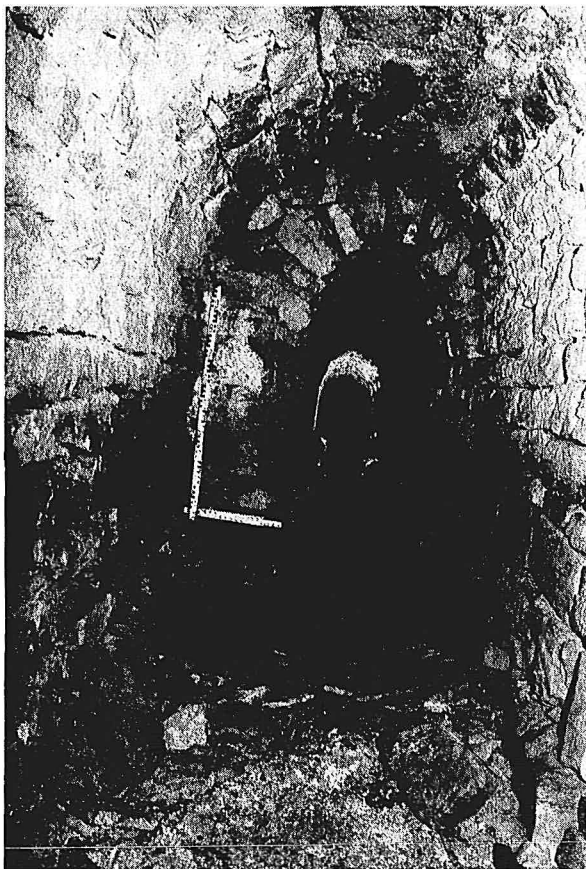
PHOTO 1. — Abbaye de Fontenay, branche nord de la canalisation à l'intérieur de la digue sur le Ru de Fontenay, elle est aujourd'hui asséchée et a été en partie surcreusée.
