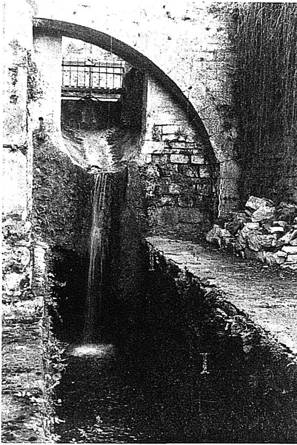
PHOTO 5. — Abbaye de Fontenay, canaux le long du mur sud de la forge. Le canal supérieur, du xix e siècle alimentait par-dessus la roue encore visible sur une photographie de la première décennie du xx e siècle ; le canal inférieur est contemporain de la construction du bâtiment.
